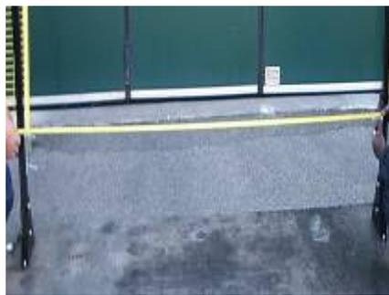
**4) posizionare e fissare a terra il montante libero**, 3-4 mm più stretto della misura del punto (3) perché con il peso delle porte rimane la stessa fessura tra le due ante
