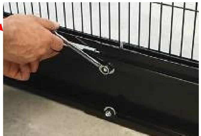
**ATTENZIONE:** se c'è la necessità di montare il parapiede in prossimità di un angolo, inserire un'estremità del parapiede all'interno del piede alla base del montante angolo, questo imprigionerà il parapiede e una volta strette le **due viti** si andrà ad impedire lo sfilarsi e di conseguenza l'uscita
