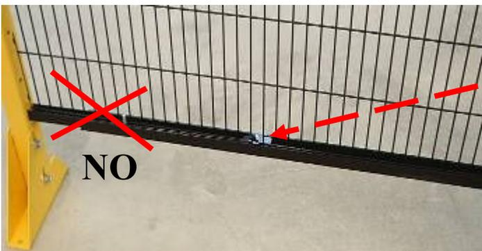
Nel caso si usi il tirante montato tutto accorciato, aggiungere una vite (m6x30) nel centro del tirante stesso e posizionare il **gancio anti vibrazione** come spiegato sopra
