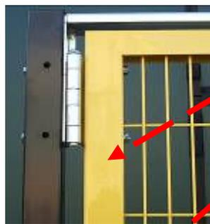
**5) montare le porte** sulle cerniere già montate al palo **usare 8 viti m6x50 con dadi**
