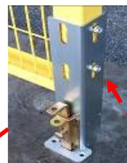
**6) regolare l'altezza del catenaccio** tramite le asole e montare il piastrello a terra dove si innesta il catenaccio con **2 tappi da muro in plastica da 8 e con viti m6x50**
