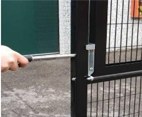
1) Per montare la **rete** a dx e sx della porta ribalta svitare i due **dadi M6**, e sfilare le 2 viti M6x50 senza toglierle per evitare la caduta della ribalta
